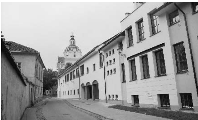
Šv. Kazimiero gatvė. Senoji erdvė sunaikinta, nes nauji namai pakeitė užstatymo liniją (ji parodyta tik grindinyje), šiuolaikiniai pastatai disonuoja su tradiciniu gatvės pobūdžiu. 2004 m.
