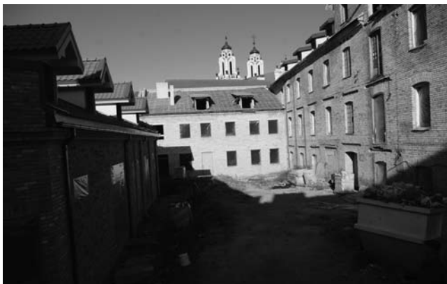
Nebūdingais naujadarais užstatomas istorinis kiemas Trakų g. 12–14
